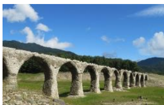
【タウシュベツ川橋梁】
