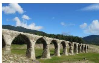
【タウシュベツ川橋梁】
