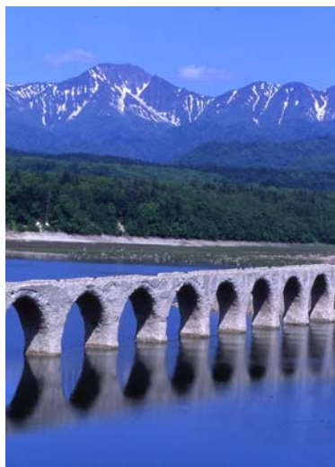
❁ タウシュベツ川橋梁
