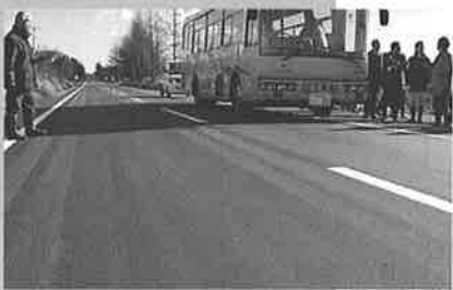
▲北門地区農道改良舗装工事
