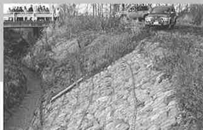
▼北門地区7号排水路災害復旧工事
