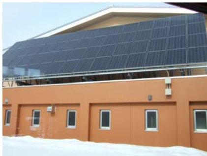
公共施設への太陽光パネルの設置
