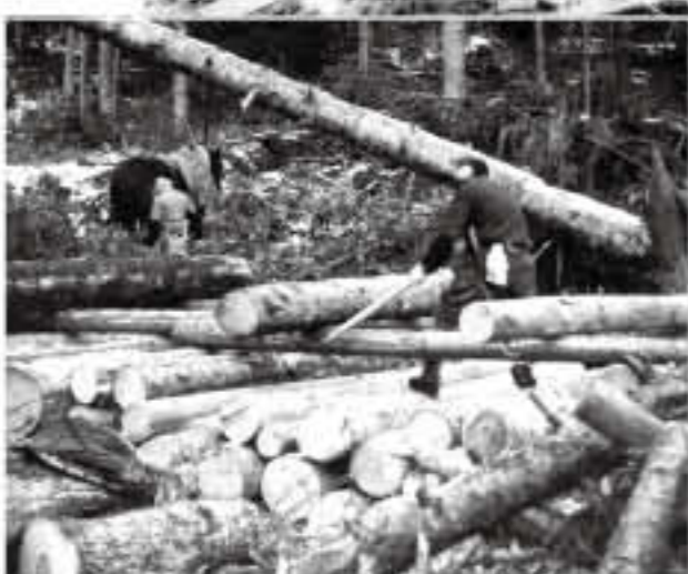
▲糠平ダム建設時の黒石平全景 ◀木なおし:土場に運びやすいよう位置や方向をそろえる作業 (写真:昭和30年頃)
