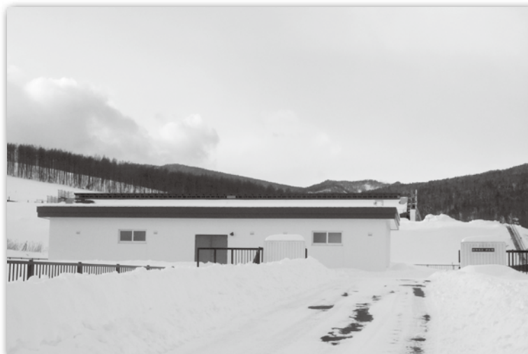
西部地区浄水場
