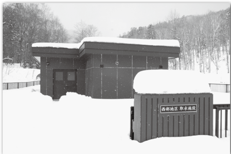
西部地区取水施設
