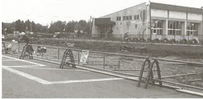
役場公用車の車庫は解体され、新施設建設の準備が進んでいます
