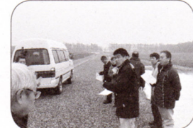
▲上士幌東4線農道改良 排水管路工事
