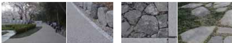
コンクリートやアスファルト（カラーアスファルト）
